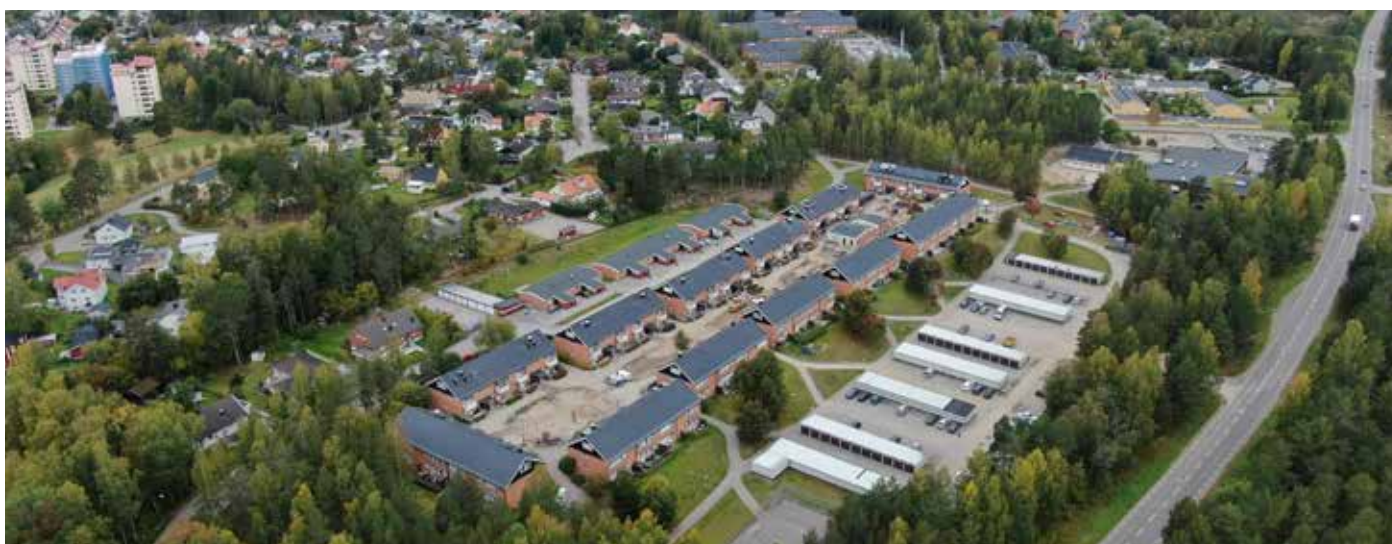
Kulvertarbete Östanbräcksvägen, Hudiksvall
