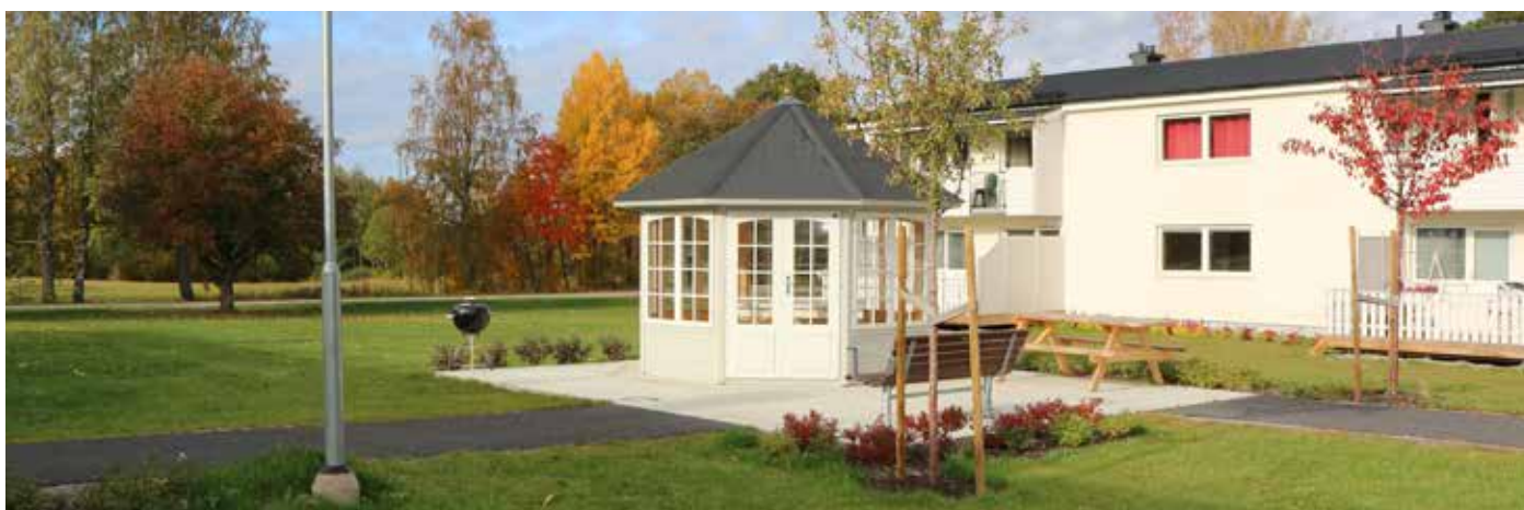
Renovering fasader och utemiljö Frejavägen, Forsa
