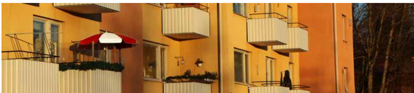
Balkongrening Reffelmansvägen, Hudiksvall
