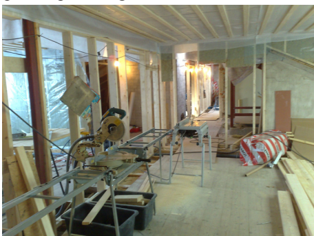
Blivande kök och vardagsrum
