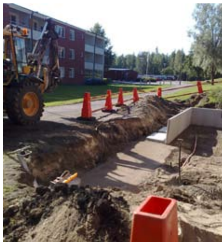
Här pågår schaktningsarbete till tvättstugan vid Gråstensgatan
