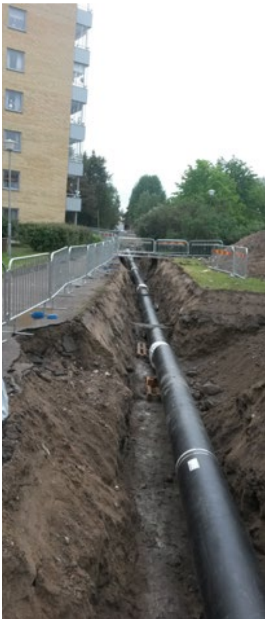
Under sommaren och hösten byttes den rörkulvert som transporterar värme till fastigheterna på Håstaskogen.
