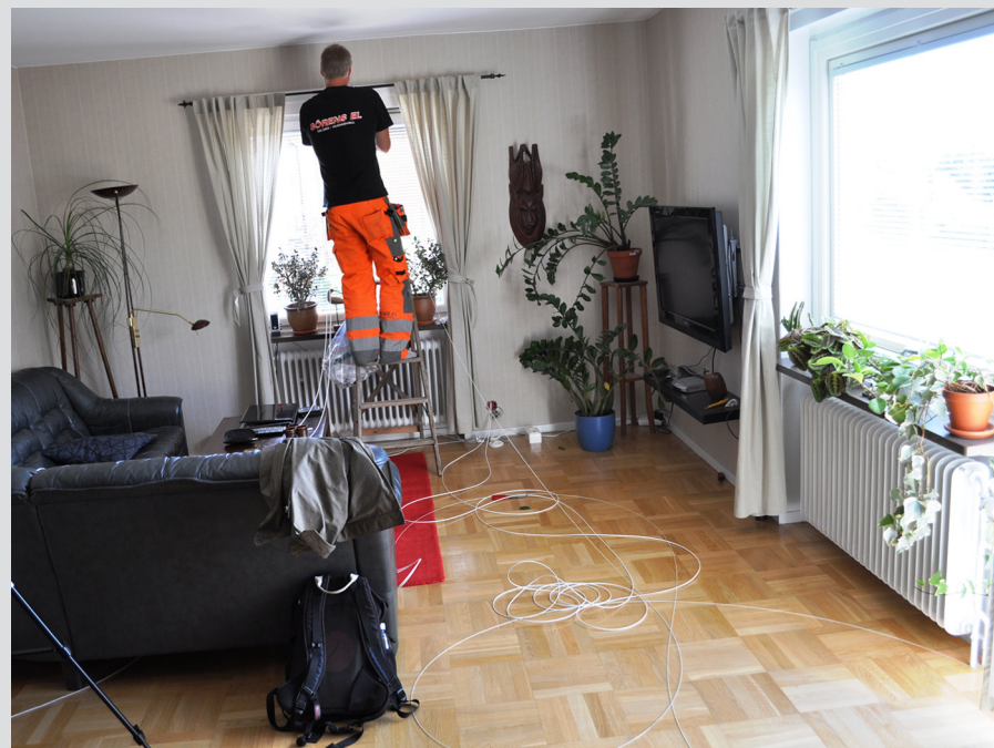
Installation av plastfiber på Vallvägen
